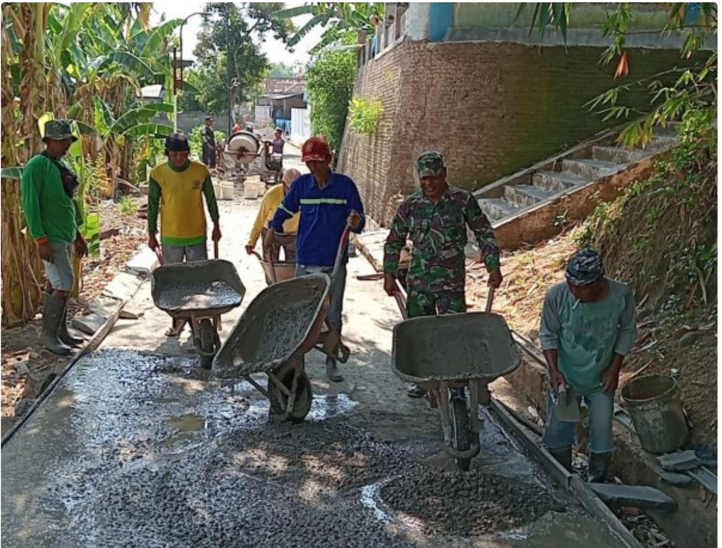
Tingkatan Infrastruktur, Babinsa Bersama Warga Karya Bakti Cor Jalan Desa Wadunggetas Klaten
